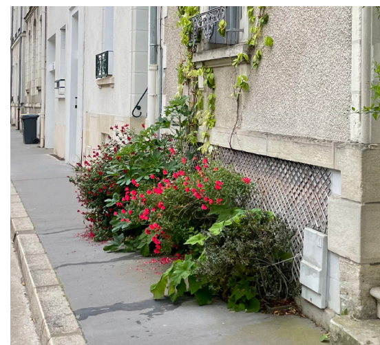
Pieds de murs végétalisés
