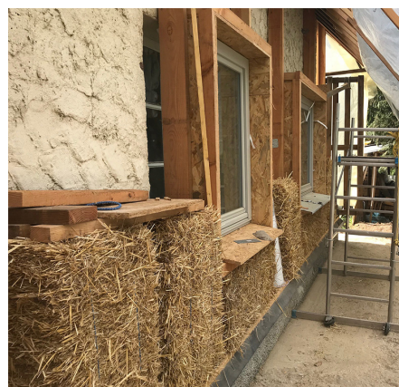
Construction en paille Source : CAUE 95
