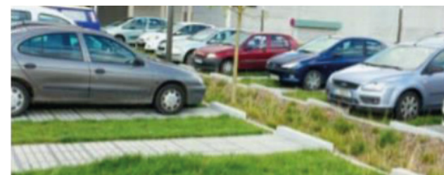
Noue végétalisée avec infiltration gravitaire du ruissellement
