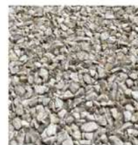
Détail de l'aspect gravillonné des panneaux.
