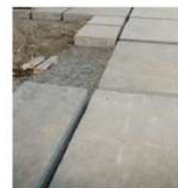
Réemploi des panneaux en dallages 60 x 120 pour traversées piétonnes et stationnements.
