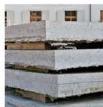
Stockage des Panneaux en béton issus de la déconstruction pour Réemploi.
