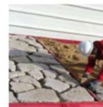
Réemploi des panneaux en opus incertum pour voie centrale.
