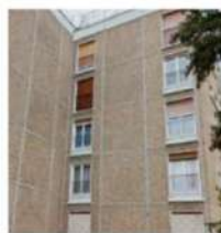
Panneaux de façade préfabriqués en béton conservés après déconstruction.
